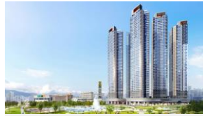
부천 중동 센트럴파크 푸르지오 주상복합·오피스텔·상업시설
